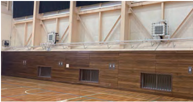
國學院大學北海道短期大学部 体育館暖房工事
