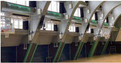
國學院大學久我山高等学校 第2体育館エアコン設置工事
